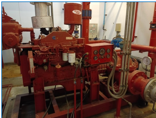
รูปที่ 15 เครื่องสูบน้ำดับเพลิง
