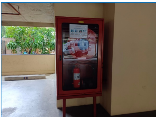
รูปที่ 17 ตู้เก็บสายฉีดน้ำดับเพลิง
