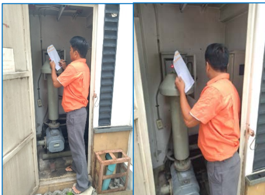
รูปที่ 35 เจ้าหน้าที่ตรวจเช็คระบบเติมอากาศของระบบบำบัดน้ำเสีย
