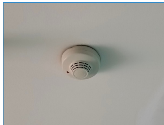
รูปที่ 22 Smoke & Heat Detector
