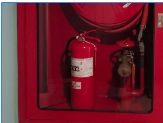
รูปที่ 19 ถังดับเพลิงเคมีชนิด A-B-C
